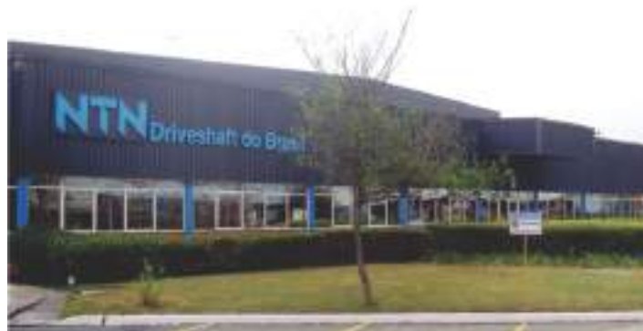
Fábrica de Semieixos - Guarulhos/SP
